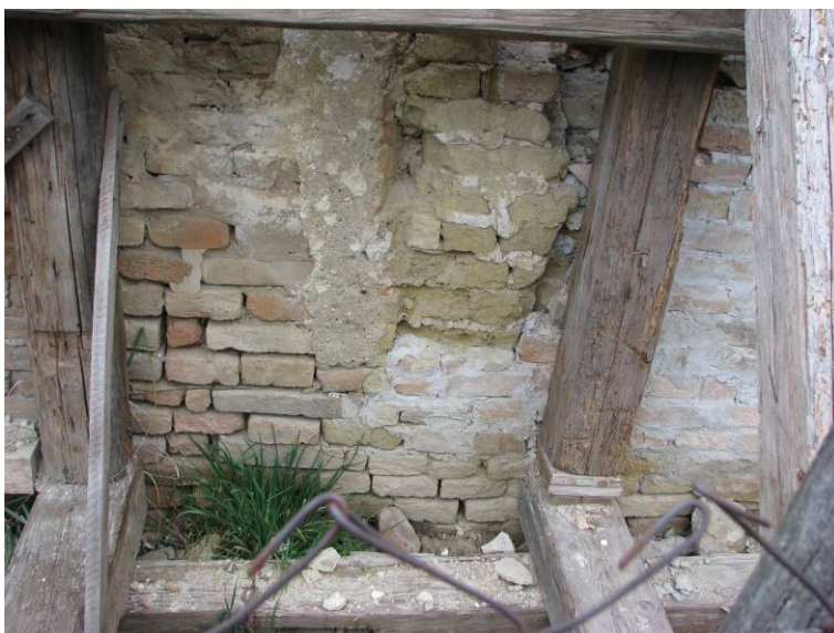
08 megtámasztott homlokzati fal.
