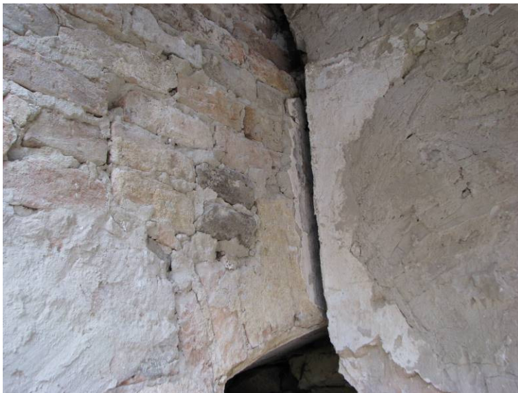
01 homlokzati fal és belső fal kapcsolata (nincs bekötés).
