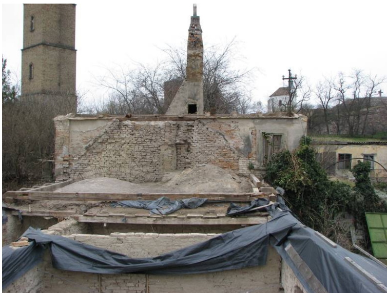
Udvari szárny boltozatok, kémény, bontandó válaszfal földszinten.
