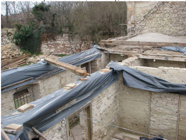
Bontandó válaszfal, és homlokzati fal.
