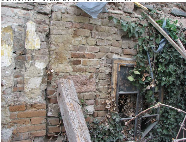
07 megtámasztott homlokzati fal.
