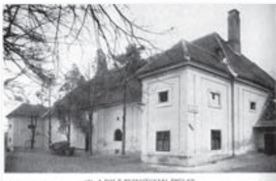
182. A VOLT PEZSGŐGYÁRI ÉPÜLET
