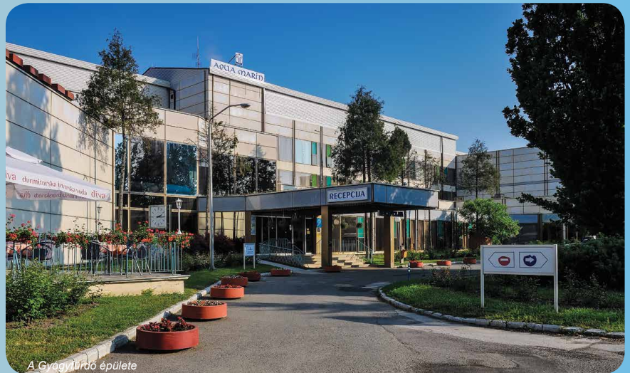
A Gyógyfürdő épülete
